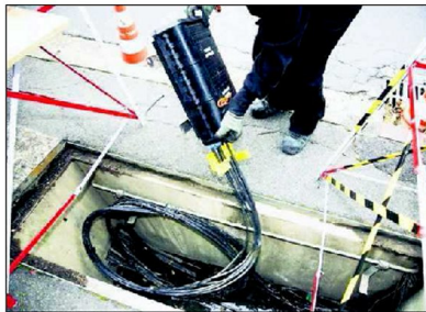
37 000 habitants, de la seconde couronne d'Angoulême, vont voir leur débit augmenter, et 215 entreprises seront raccordées à la fibre optique entre 2015 et 2016.
